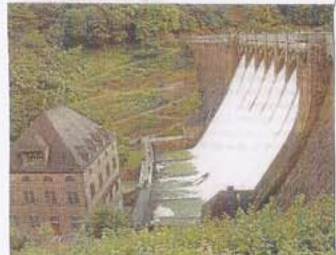
Seltenes Schauspiel: Die überlaufende Diemeltalsperre ist nicht häufig zu bewundern, trotzdem sind der Diemelsee und die Staumauer immer ein lohnendes Ausflugsziel.
